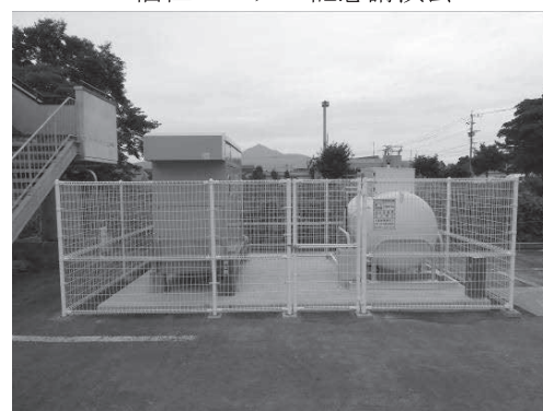
非常用発電装置設置工事完了
