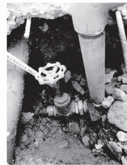
水道管断裂(うちだ2番館)
