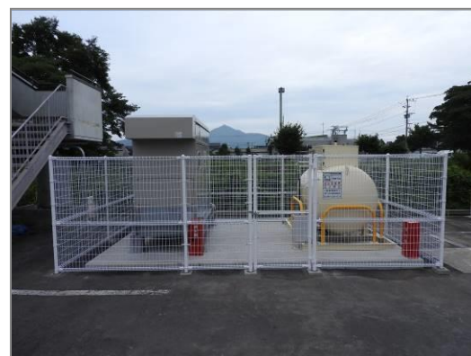
非常用発電装置設置工事完了
